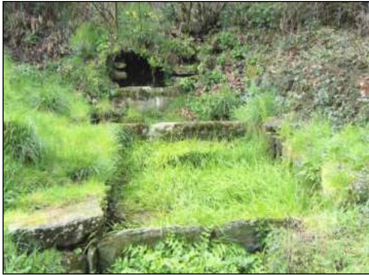
Lavoir avant travaux
